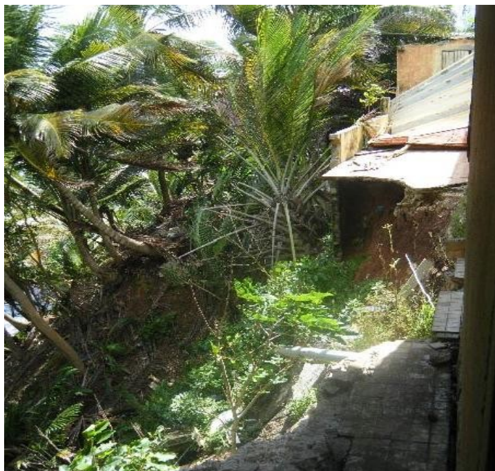
Point-à-Bacchus : construction en zone de glissement © CANBT
