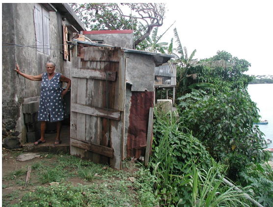
Construction en bordure de falaise
