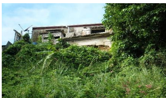
Bovis : construction à flanc de falaise © CANBT
