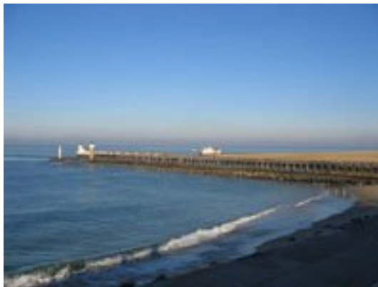
Impact de la digue nord : forte accrétion au nord et érosion au sud
