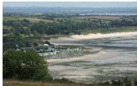
St Jean-le-Thomas : l'enrochement et au second plan le cordon dunaire qui s'étend vers le sud en direction de Dragey
