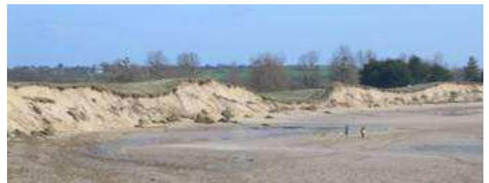
Ici, le cordon, très fragile, menacé de rupture, est particulièrement surveillé.
