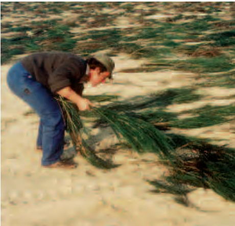
Photo 5.14 Etalement manuel d'une couverture plane de genêts, sur la côte aquitaine (Gironde) en France. © ONF/JF Office National des Forêts/Jean Favennec
