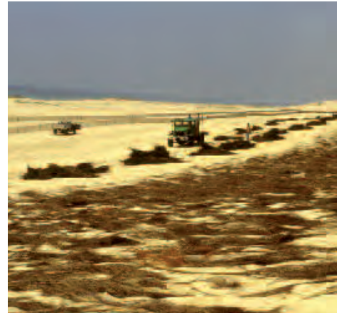
Photo 5.15 Réalisation d'une vaste couverture de genêts (avant plantation d'oyats) sur le chantier de réhabilitation des dunes du Cap-Ferret, terrain du Conservatoire du littoral, en Aquitaine. © ONF/JF Office National des Forêts/Jean Favennec
