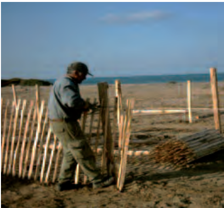
Photo A.17 Travaux de mise en place des ganivelles. © Melhaoui Mohammed / Latifa Elhafid
