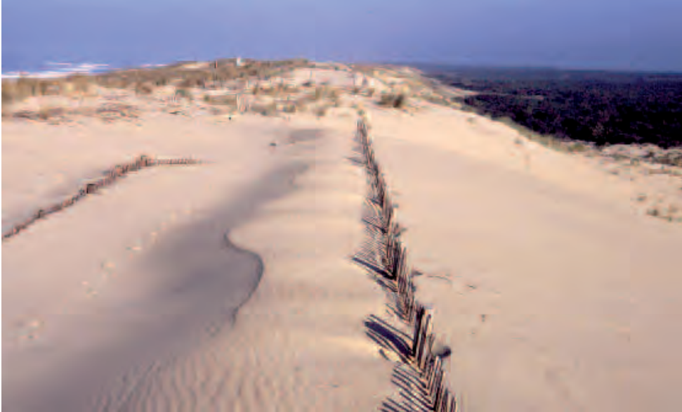
Photo 5.12 Pose de Ganivelles dans la partie arrière du cordon dunaire, en France sur la côte atlantique, La Coubre en Charente -Maritime. © ONF/JF Office National des Forêts/Jean Favennec
