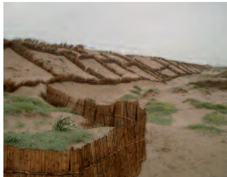
Photo 5.10 Brise-vent en spartine installé. Le premier rang est une ganivelle de clôture. © Carlos Ley
