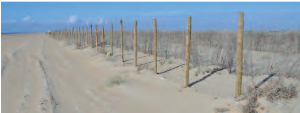
Photo 5.22 Clôture en bois et grillage métallique. © Carlos Ley
