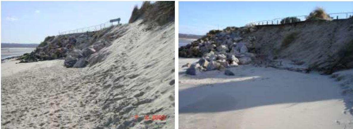
Recul de la falaise sableuse de 2003 à 2007 et étalement des blocs sur la plage (photos Y. B-Q)
