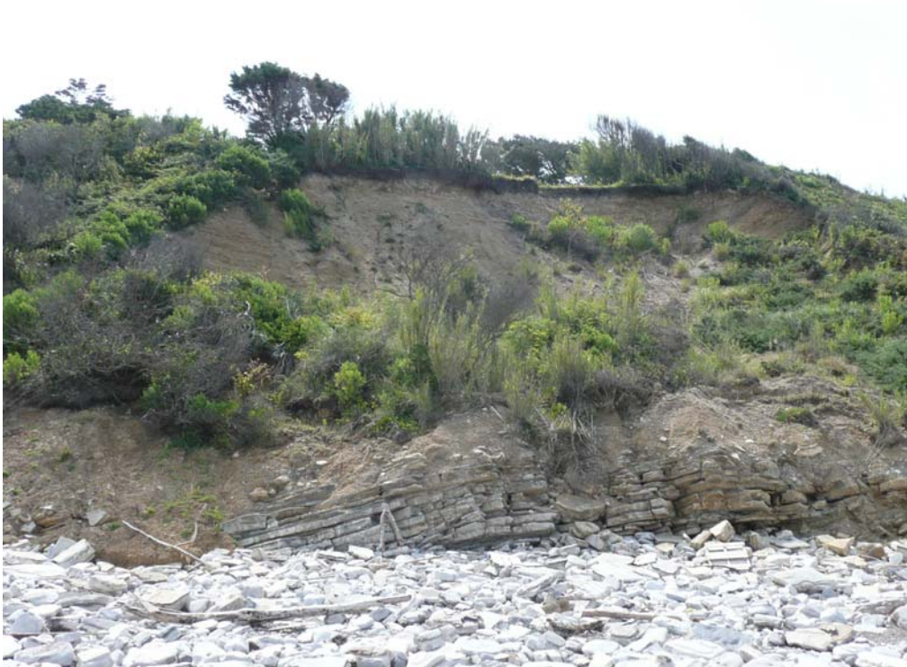
Glissement de terrain d'Harotzen Costa en juillet 2008
