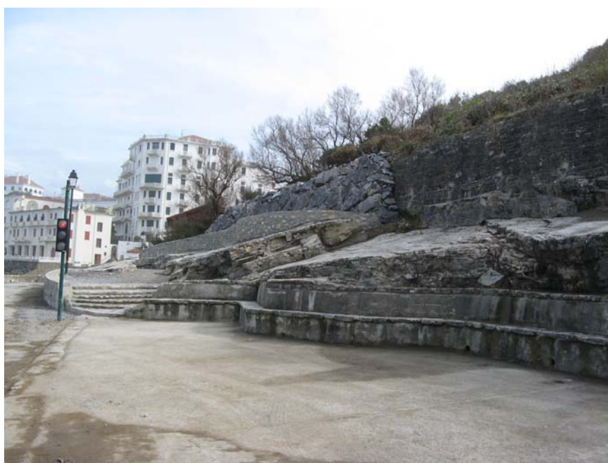
Photos du mur réhabilité (mars 2008)
