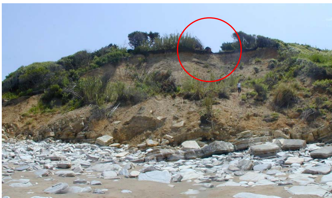
Glissement de terrain d'Harotzen Costa en juin 2006
