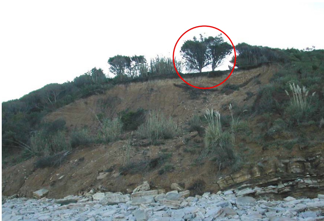
Glissement de terrain d'Harotzen Costa en octobre 2005
