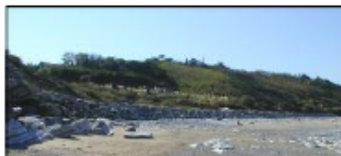
Enrochement sur la plage d'Harotzen Costa
