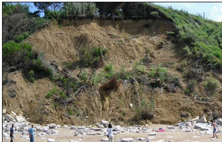
Fig. 17 : Glissement circulaire survenu à Guéthary en janvier 2004
