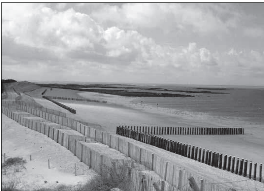
Photo 1 : Protections côtières dans le secteur des Éloux (2007) Shoreline defence structures along Les Éloux beach
