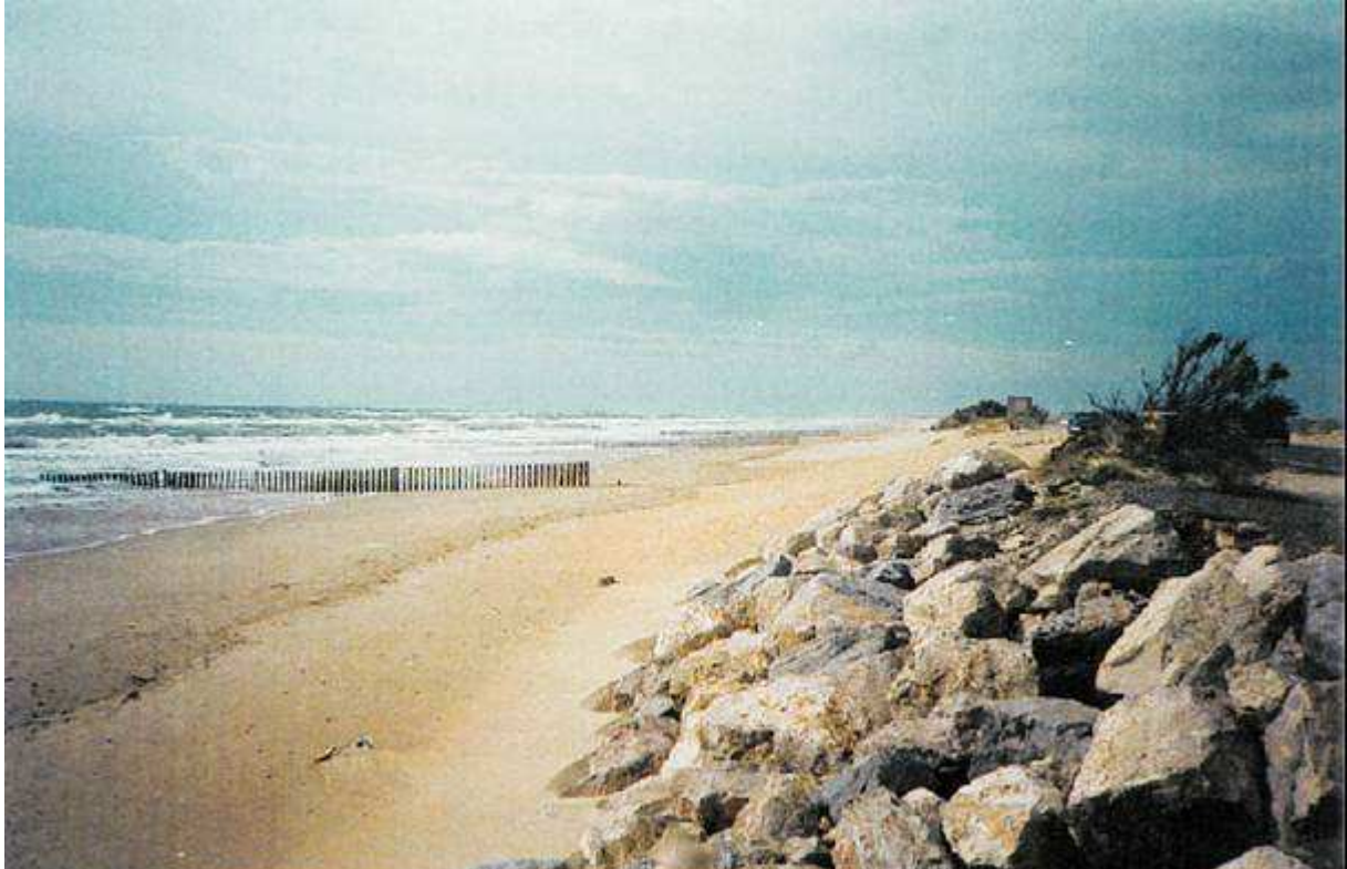
Photo 3 Epis perméables en pieux, 3,5 km au sud-ouest de la plage de la Corniche (cliché H. Heurtefeux, 1997)
