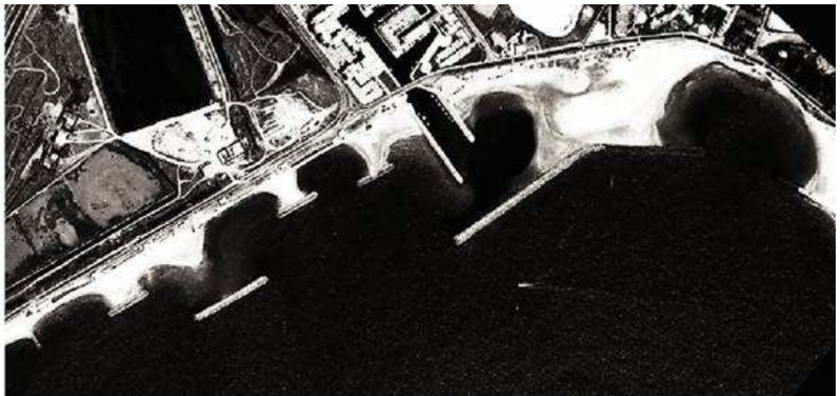
Photo 2 Vue aérienne des épis et brise-lames de la plage de la Corniche à Sète (cliché IGN, 1997) La plage a disparu entre certains de ces ouvrages
