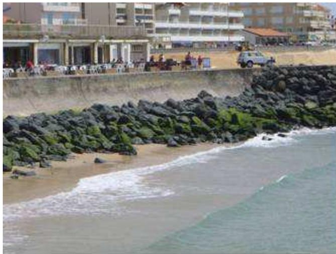
Photo 6. Le démaigrissement de la plage de l'Estacade au devant du perré et des enrochements de défense du front de mer. (cl. C. Clus-Auby, 2005).
