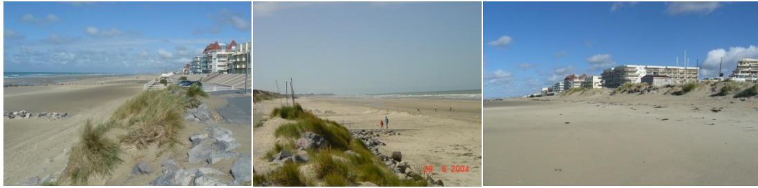
Figure 8: l'enrochement installé au sud de Merlimont est régulièrement ensablé.
