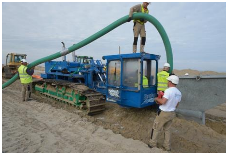
Mise en place du système de drainage sud
