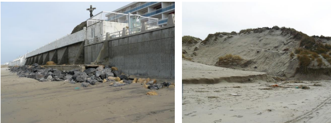
Figure 11 : à gauche, la digue de Merlimont en mars 2008 quatre jours après une tempête (marée à gros coefficient combinée avec une mer forte et des vents violents). La photo a été prise à marée basse. Le sable de la plage est humide et on reconnaît les traces de courants de retour perpendiculaires à la digue. À droite, même jour, à quelque centaines de mètres au sud, devant la base nautique, la dune est entaillée en falaise mais le sable de la plage est sec (le niveau de la plage est plus haut qu'au droit de la digue).
