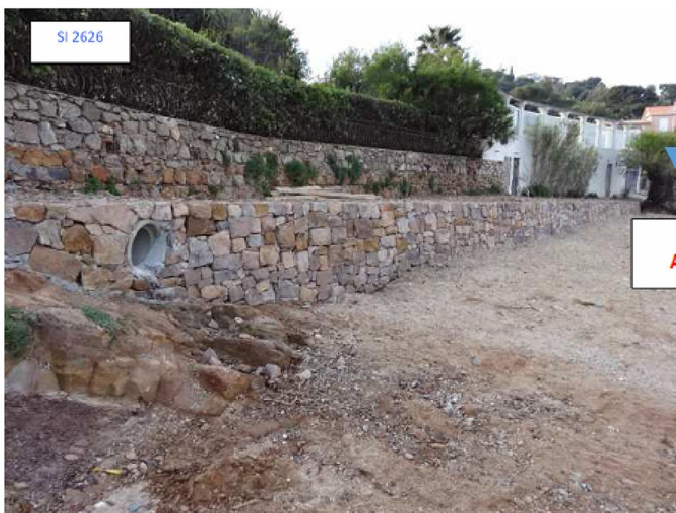
Ouvrage en parpaings à bancher ferrailés et fondés au rocher avec habillage maçonné sur la face aval
