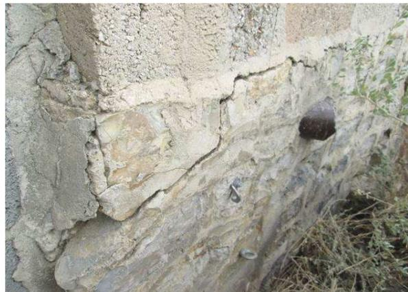
Début 2014, l'affouillement généré par cet écoulement intempestif a généré le glissement des fondations du mur et l'écroulement des murs de soutènement de la plate-forme obligeant à la fermeture du sentier sur ce tronçon.
