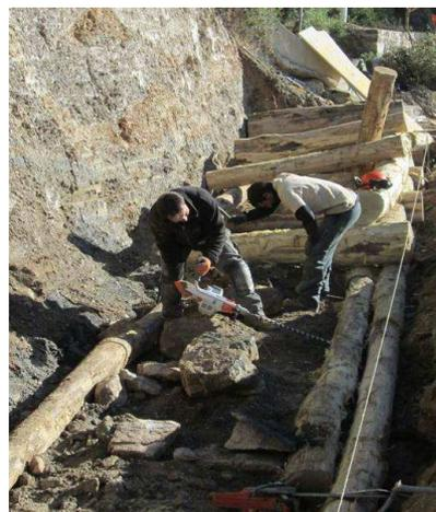
Les vagues pouvant développer des forces verticales, du bas vers le haut (inverses à la pesanteur), les liaisons entre l'ouvrage (traverses et longrines) et le sol sont renforcées.
