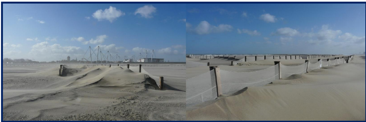
Figure 14 : Illustration des filets brise-vent visant à stabiliser les envols de sable sur le rechargement de plage de la digue des Alliés (GPMD, 2016)
