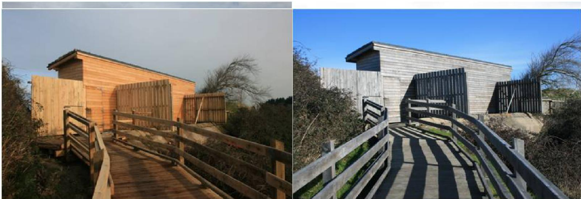
Vues de la fin des travaux sur l'observatoire (RNNPO/EDEN62 - A.D.)
