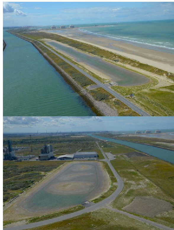
Figure 5 : Vues aérienne des bassins salés, en haut bassin nord, en bas bassin sud
