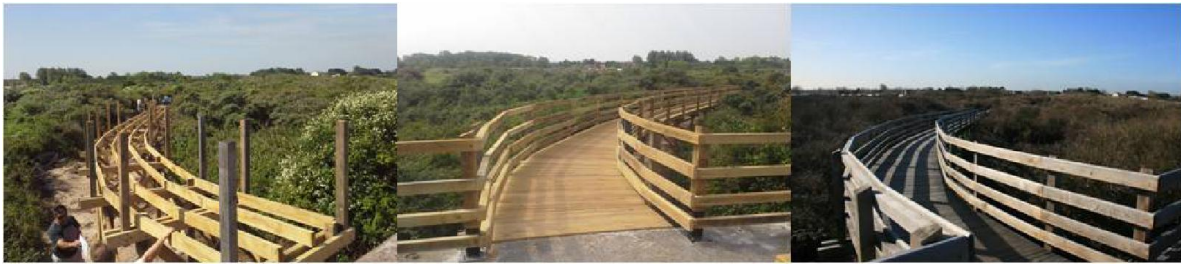
Vues de différentes phases de création de la rampe sud, d'accès au sommet du blockhaus, prises depuis le sommet du blockhaus. A gauche squelette de la rampe, au centre rampe le jour de son achèvement, à droite rampe achevée depuis 8 mois. (RNNPO/EDEN62 - A.D.)
