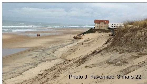
La mer a repris une partie du sable apporté lors du rechargement de la plage, il en résulte une « pseudo falaise »...
