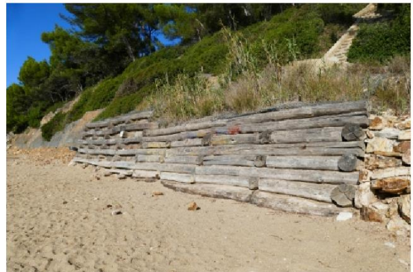
Un dispositif de maintien du pied de falaise inspiré des travaux menés par l'ONF en montagne...
