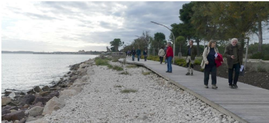
Confortable promenade maritime réalisée en bordure de plage...
