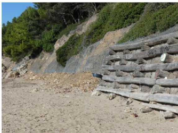
Différentes techniques de stabilisation de la falaise...
