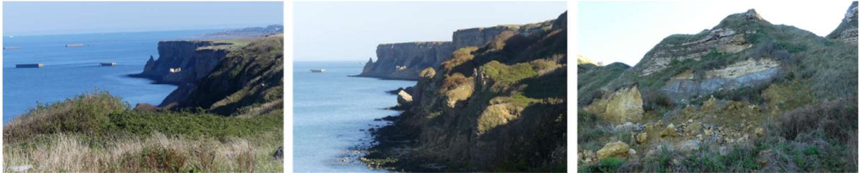
Falaises de Longues-sur-Mer : chaos de blocs rocheux issus d'effondrements successifs dans une alternance de calcaires et de marnes... (photos JF)
