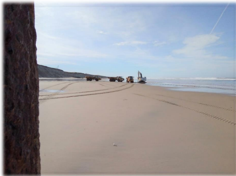
Photo 6 : prélèvements de sable sur l'estran de la DGA-EM, au sud des piquets de limite (février 2021), à plus d'1 kilomètre de la plage à recharger ©CCGL
