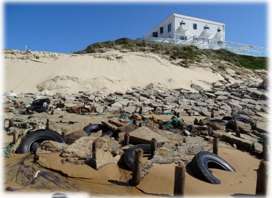
Photo 7 : plage au droit du Grand Hôtel laissant apparaître d'anciens pieux en bois traduisant une baisse de plage rarement atteinte, 02 avril 2020 ©CCGL
