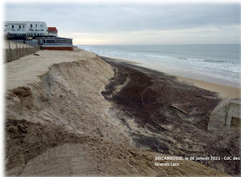
Photo 5 : plage centrale, avec blockhaus apparent et recul de la dune de plus de 15 mètres, 06 janvier 2021 ©CCGL
