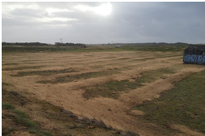
"Bassin à crevettes" en fin de travaux de dépollution
