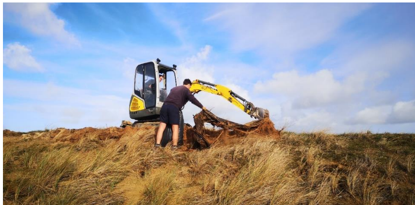
Travaux mécaniques d'enlèvement des bâches et autres déchets
