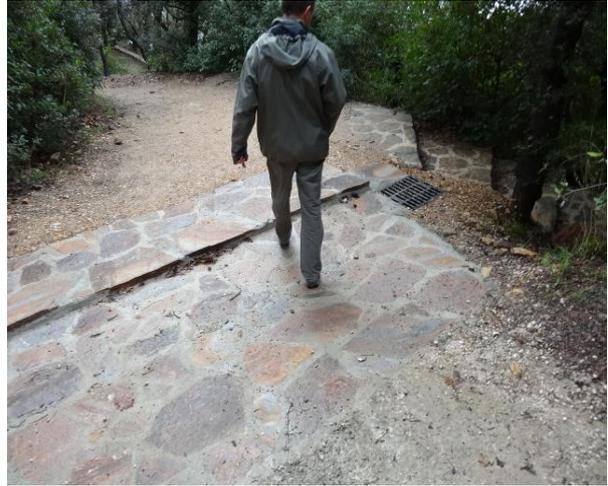
Collecte des eaux superficielles : Mise en place une canalisation aérienne en préfabriqué ciment en tête de versant
