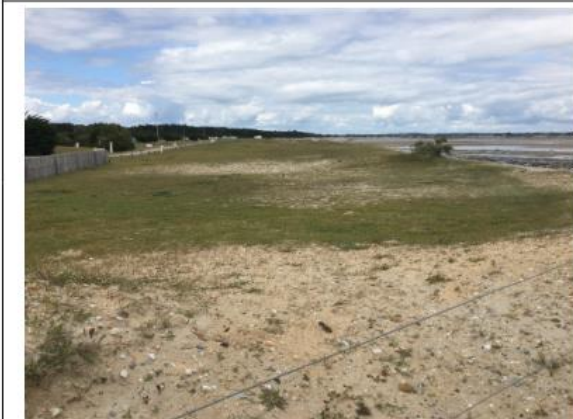
Le camping municipal a reculé son implantation afin de ménager un espace de reconstitution d'un cordon dunaire de protection en interaction dynamique avec la plage... (photo JF)
