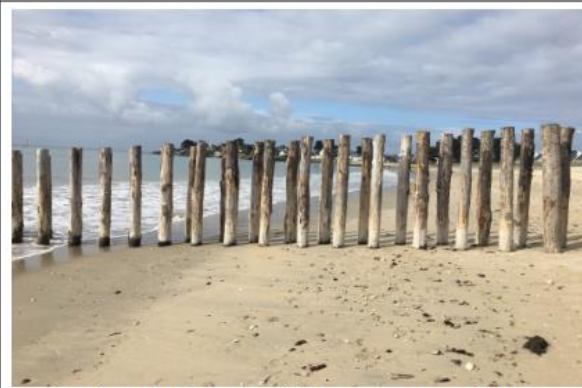
Sur la plage un épi perméable de poteaux bois vise à limiter la perte de sédiments, il a l'avantage de permettre les transits longitudinaux. Des mesures sont effectuées pour évaluer son efficacité. (Photo Jean Favennec)
