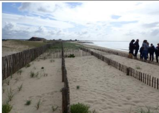
Ici, une largeur non urbanisée suffisante a permis la formation d'un cordon dunaire de protection par pose d'un réseau de ganivelles... (Photo LG)
