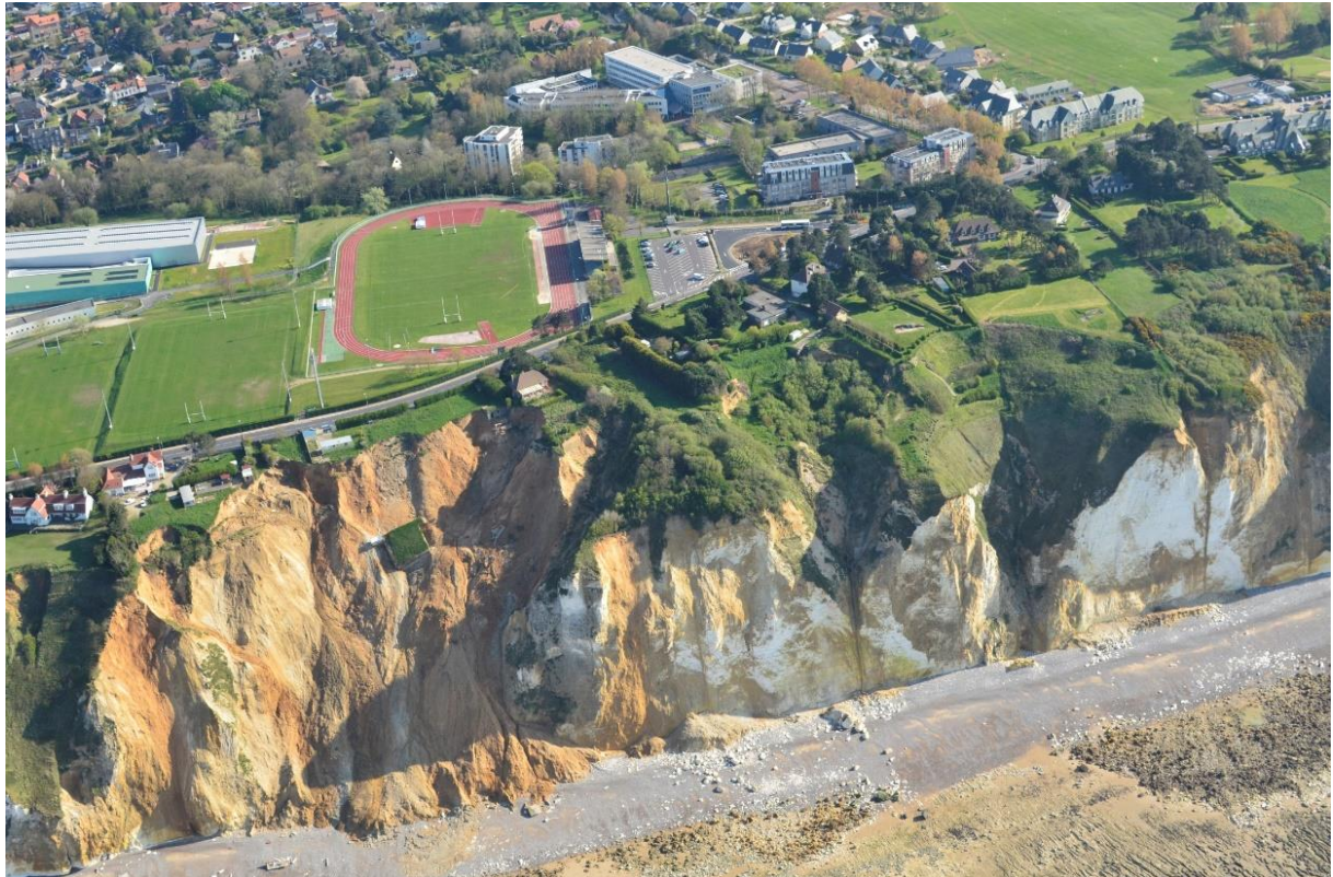
Figure 2 : Glissement de terrain en avril 2014 (BRGM)
