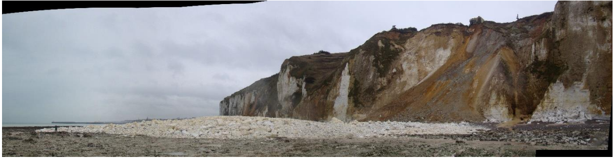
Figure 1 : Zone de propagation des éboulis sur le platier en décembre 2012 (BRGM)
