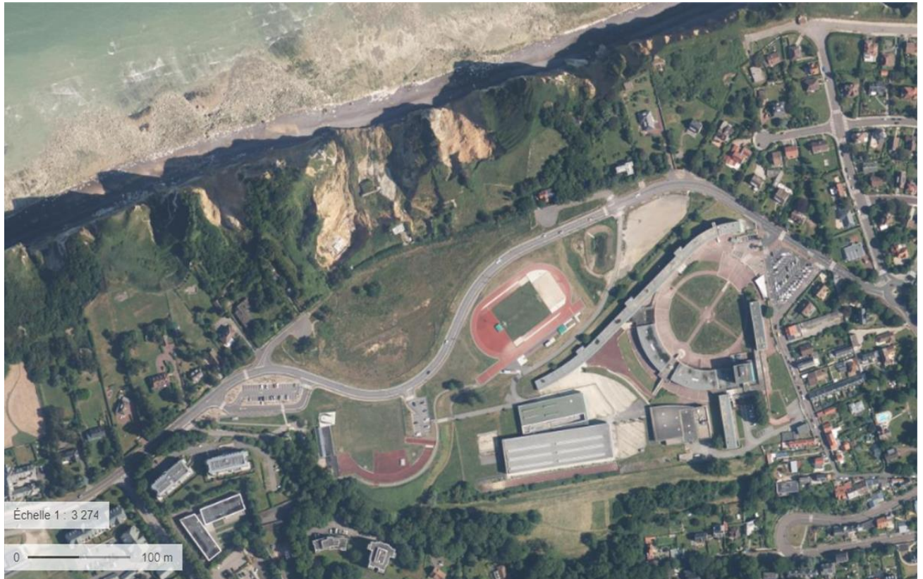
Figure 6 : Tracé de la reconnexion de la RD 75 (Conseil Départemental), travaux débutés en juin 2019
