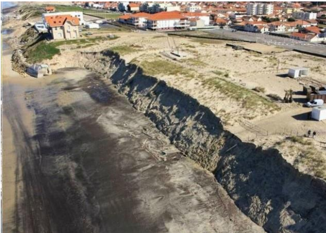
Document 4 : photographie de la plage sud de Biscarrosse après la série de tempêtes de l'hiver 2013/2014, ici en mars. Géotextiles et accès plages ont été détruits, laissant place à une falaise de plus de 6 mètres de hauteur. Le recul enregistré par endroit atteint 25 mètres ©SPAD 2014.
