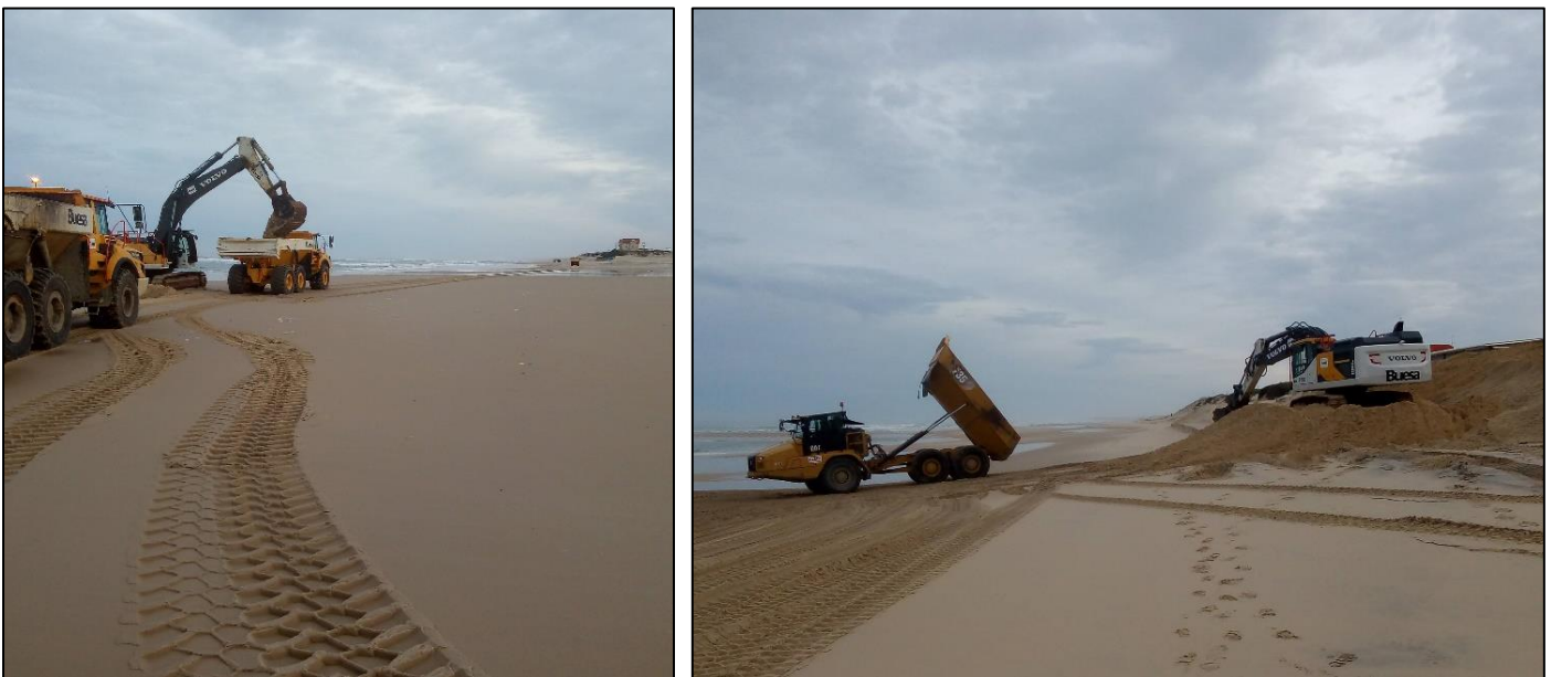
Document 8 : illustration des opérations de transferts sédimentaires mécaniques (rechargements en sable). A gauche, les prélèvements, ou emprunts, à droite, les dépôts en haut de plage et/ou pied de dune, à + d'un kilomètre au Nord (©CdC des Grands Lacs, Biscarrosse le 21 mars 2023)
