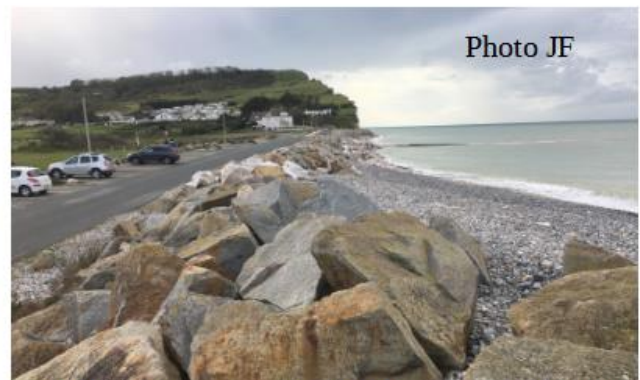
En front de mer le cordon de galet est peu alimenté car une grande partie de ces sédiments est captée par les sites amont-dérive... La question de la cohérence des ouvrages de défense avec la GEMAPI est posée...
