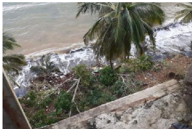
Nouveaux glissements à Petit-Bourg
