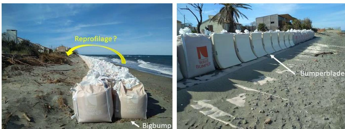
**Figure 81 : Bigbump® installés sur une centaine de mètres (à gauche). Modules amovibles Bumperblade® avec géotextile sur une dizaine de mètres en partie nord du dispositif (à droite).**
