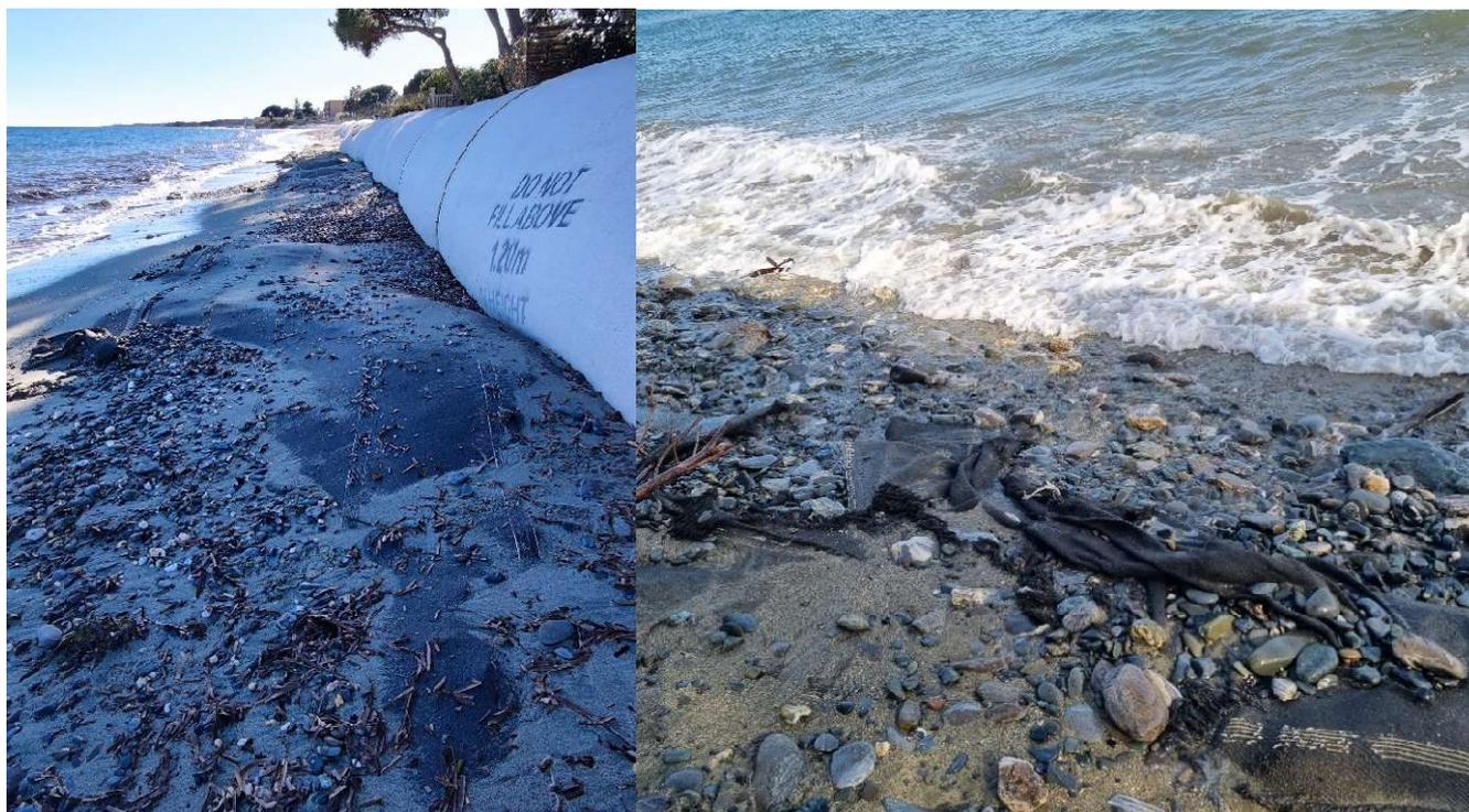
**Figure 74 : Dégradation tapis anti-affouillement janvier 2024 à gauche, octobre 2024 à droite (© BRGM).**
