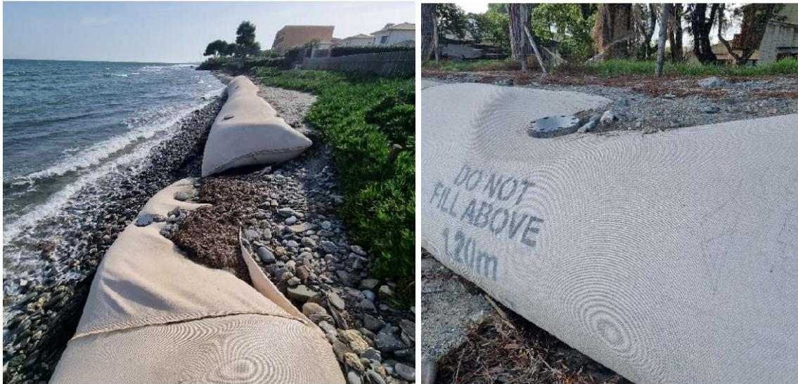
Figure 77 : Tassement et déformation au niveau des bouches de remplissage (octobre 2024).
