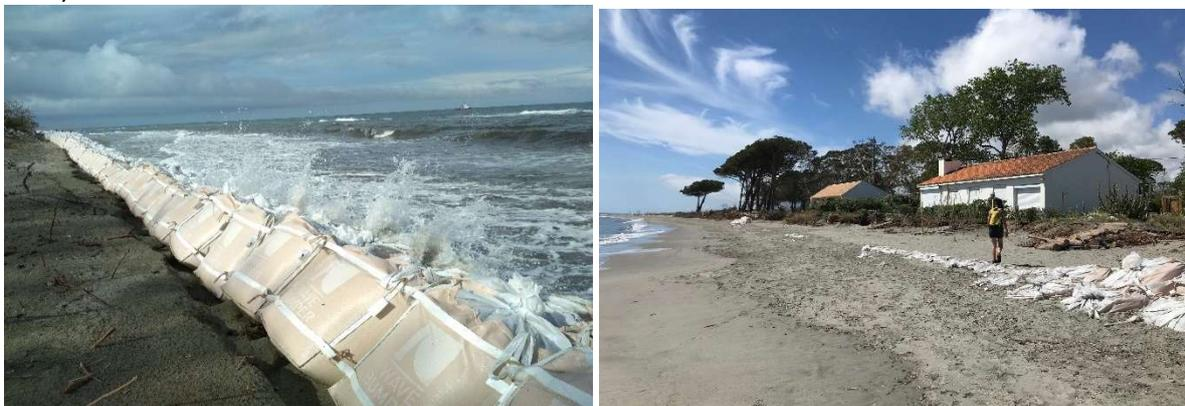
**Figure 83 : Affouillement et basculement du partie des Bigbump®. La mer atteint encore le dispositif de protection le 12/04 (à gauche). Enfouissement des Bigbump® le 21 mai 2021.**
