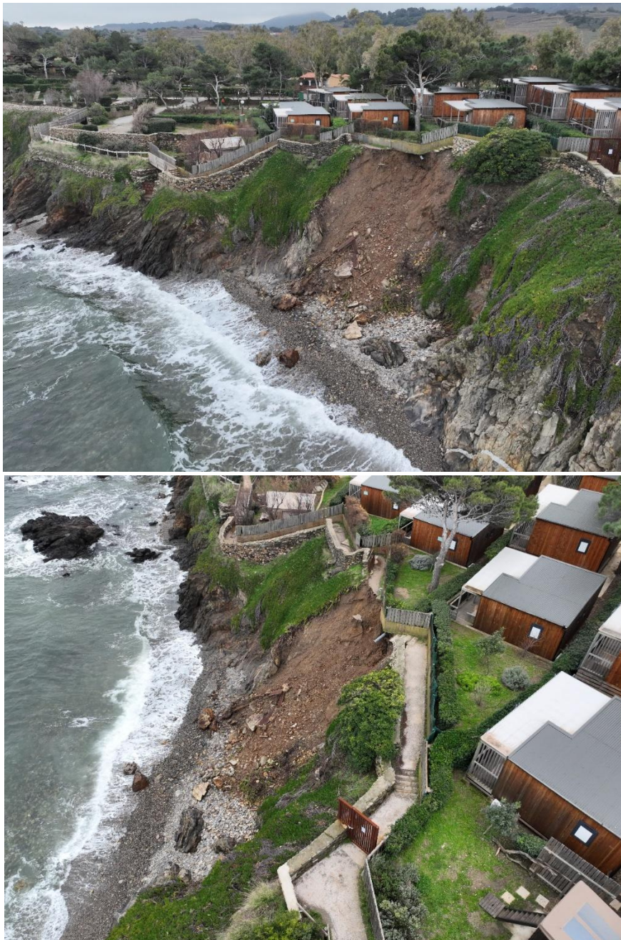
Vues aériennes (drone) du glissement de terrain entre la plage de Portails et la plage de l'Ouille – (Source CCACVI 2026)
