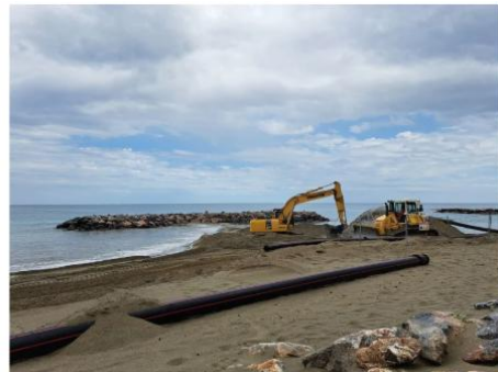
Confortement du baladoir en pied de dune et/ou ouvrage en 2025 : pose de Big Bag en pied de dune. Rechargement au printemps 2025.
