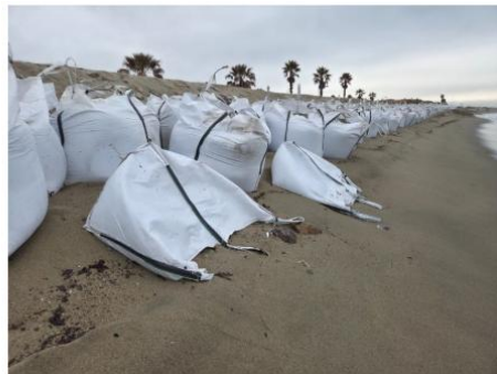
Confortement du baladoir en pied de dune et/ou ouvrage en 2025 : pose de Big Bag en pied de dune. Rechargement au printemps 2025.
