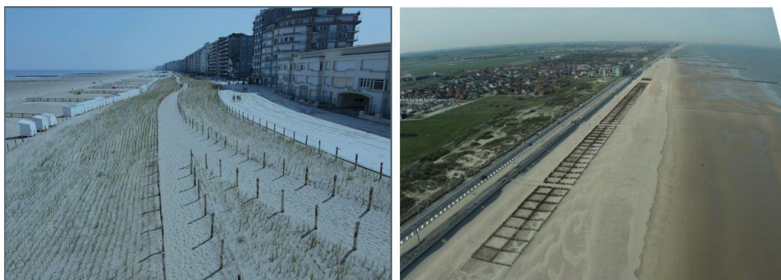
Figure 1. Exemples de systèmes dune-digue en Belgique : Middelkerke (gauche) et Living Labs Raversijde (droite).
