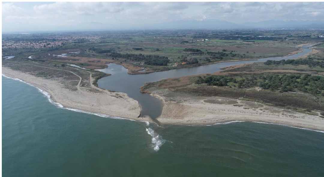
Figure 2 : L'embouchure du Bourdigou immédiatement après l'enlèvement des enrochements lors de l'hiver 2026.
