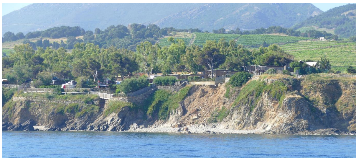
Eboulement au droit du camping
