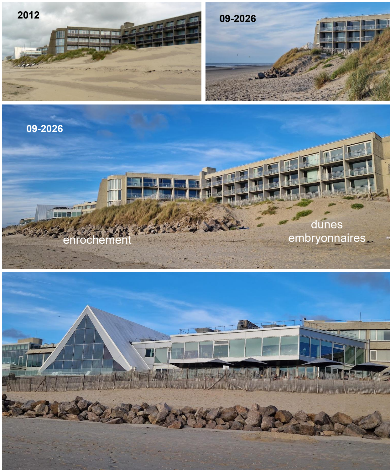
Fig.3. Le centre de thalassothérapie du Touquet-Paris-Plage , construit en 1974, en haut de plage, dans la zone de mobilité du trait de côte. Paradoxalement, sur cette côte en accrétion, les propriétaires du centre doivent protéger le bâtiment des vagues de tempête en installant un enrochement, juste à côté d'une zone d'accumulation éolienne qui menace d'ensabler les fenêtres des chambres. C'est pour eux la seule façon économiquement acceptable de répondre à la mauvaise implantation choisie en 1974. C'est un bel exemple de construction faite en méconnaissance complète du fonctionnement du système côtier.
